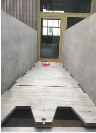
Bild 17. Nachträgliche Verlängerung der Brückenplatte in die Fassade hinein mit knochenförmigen Verbindungsstücken in CPC und nachträglicher Vermörtelung (Quelle: CPC AG)
