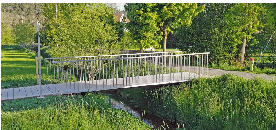
Bild 16 Endprodukt der Brücke Turbenthal Finished bridge in Turbenthal (ZHAW)
