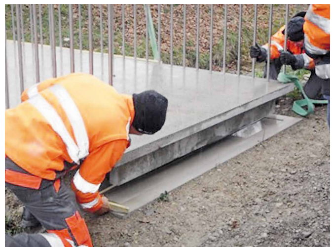
Bild 5 Quersteg, Auflagerplatte und verdichtete Sand-/Kiespackung Cross bar, support plate and compacted sand/gravel packing (CPC-AG)
