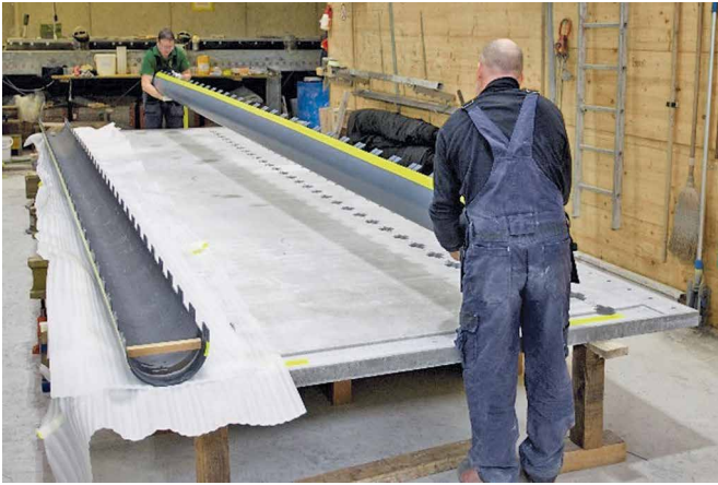
Bild 13 Verbau der CFK-Bohlen (23 kg/Stk) mit dem Brückendeck Connection of the CFRP beams (23 kg/piece) with the bridge deck (CPC-AG)
