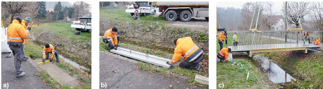
Bild 15 Versetzarbeiten vor Ort: a) Erstellung Sand-/Kieskoffer; b) Versetzen Auflagerplatte; c) Versetzen der Brücke Work on site: a) creation of sand/gravel packing; b) positioning of support plate; c) positioning of bridge (ZHAW)
