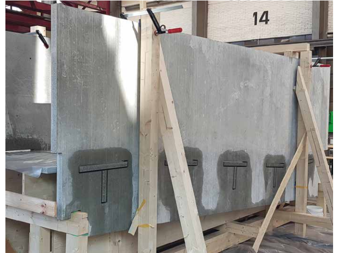
Bild 15. Zusammenbau der Brücke und Ausmörteln der Verbindungen (Quelle: CPC AG)
