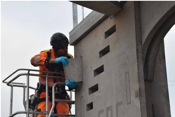
Bild 21. Überstülpen des Turmelements auf den Verankerungspfahl, Montage des Kragelements und Setzen des Sicherungssteins (Quelle: CPC AG)
