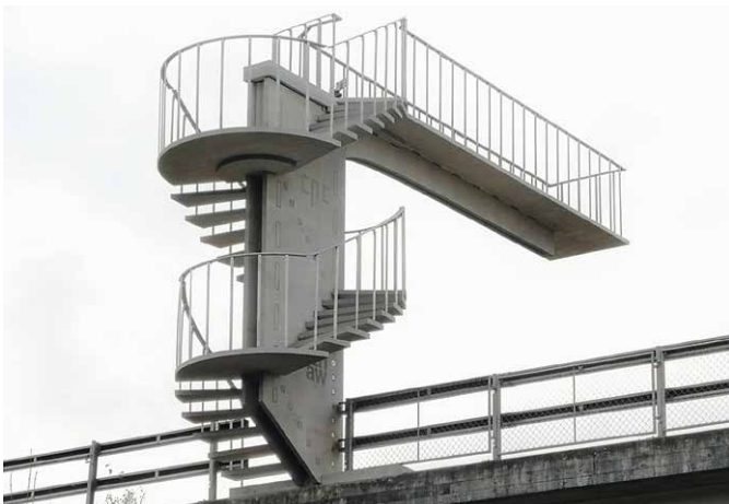
Bild 22. Fertiger Turm mit den eingesteckten Plattformen und Tritten (Quelle: Fachgruppe FVK ZHAW)
