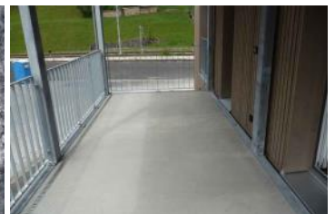
CPC Platte nach der Montage.
